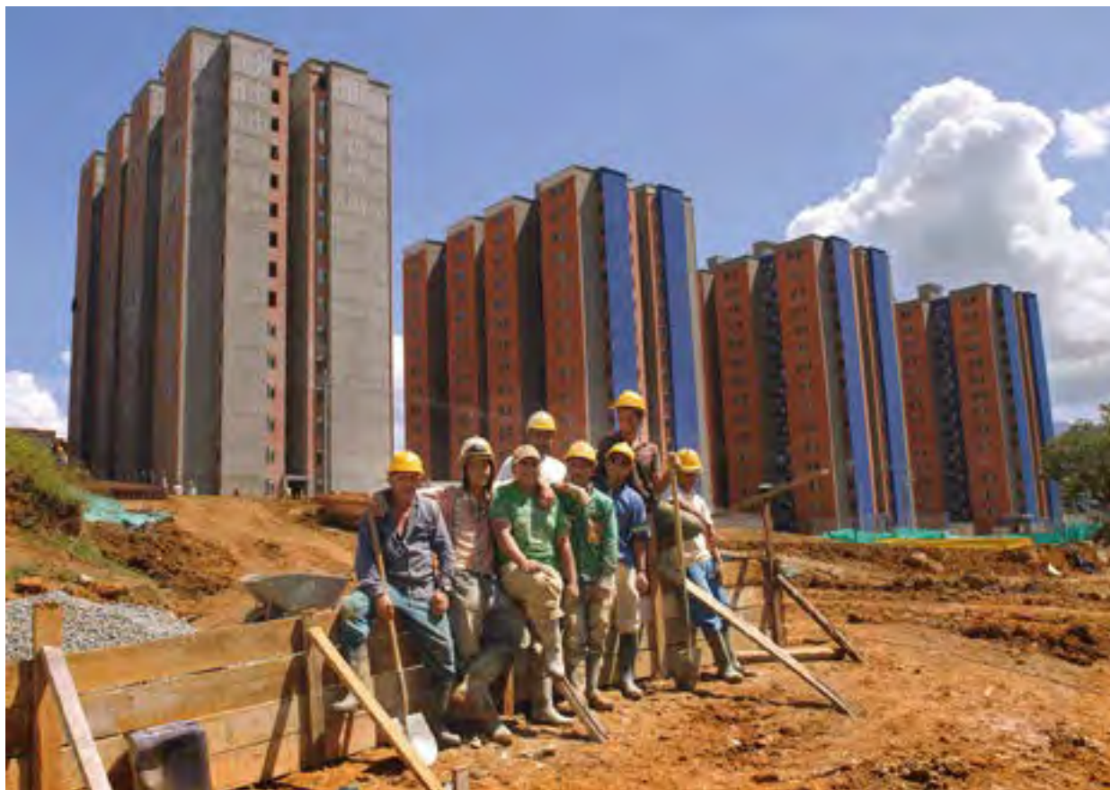
Construyendo el futuro en la Urbanización Paisajes.
